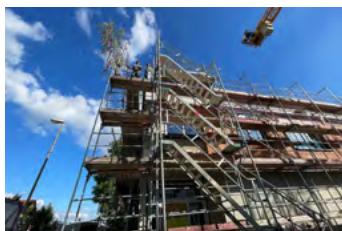
Fotos vom Baufortschritt / Quelle: privat
